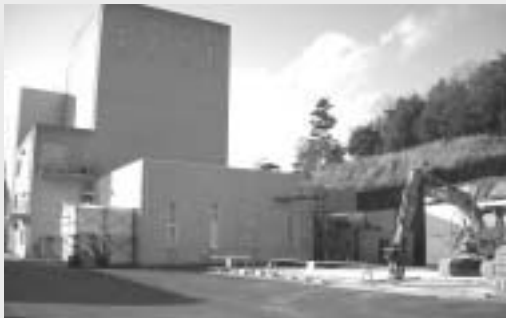
豊能郡美化センター 施設解体撤去工事始まる
