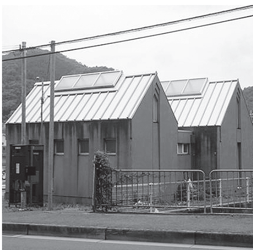
道の駅トイレ
