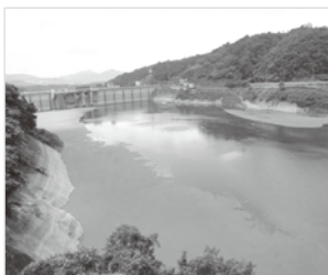
阪神地区の水がめ、一庫ダム
