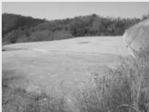
旧資源ごみ選別ヤード裏から (平成24年4月12日撮影)
