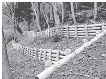
森林組合豊能支所(大里)に集められた間伐材は丸棒加工され、様々な用途に活用されている。
