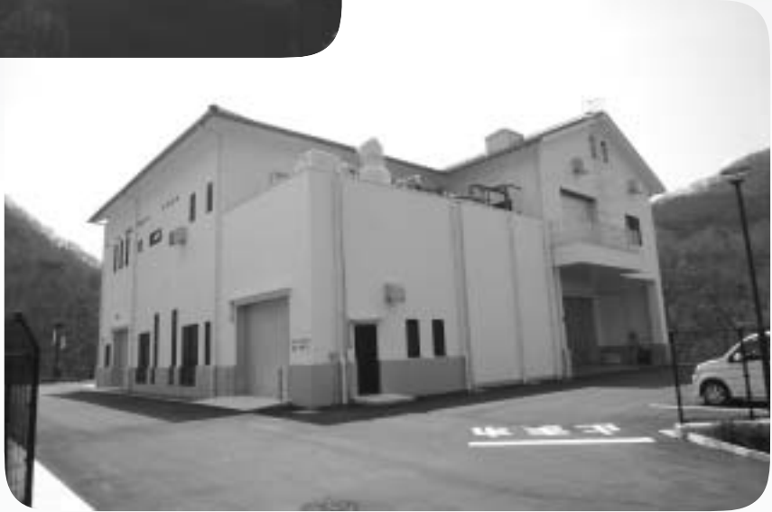
し尿処理場全景 →
