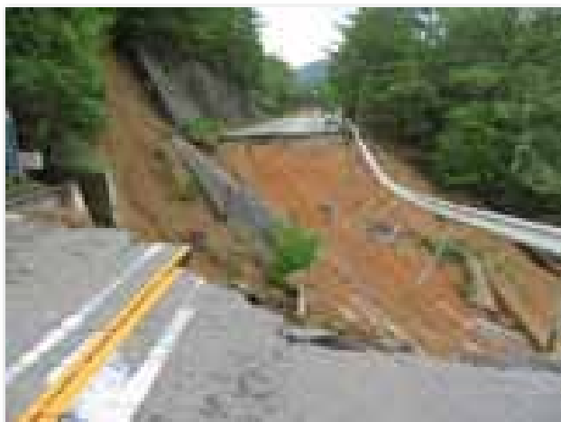
国道173号線(山辺口天王間)
