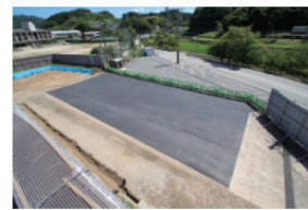
【工事完了後の施設】
