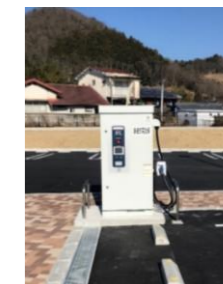
▲EV急速充電設備
